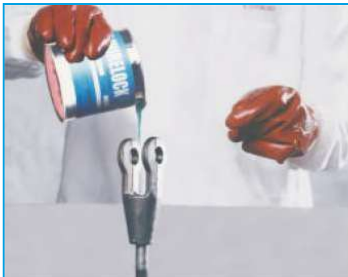
Po wymieszaniu składników należy niezwłocznie wykonać zalewanie (Rys. 7.).
