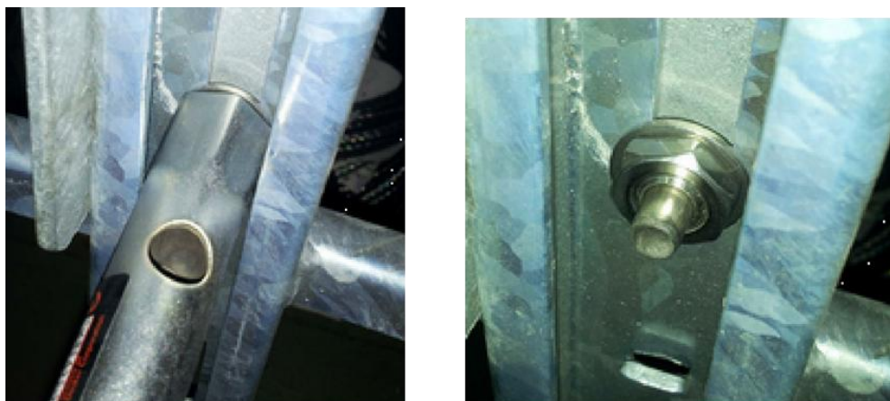
Figure 7: Installation des écrous et position de montage
