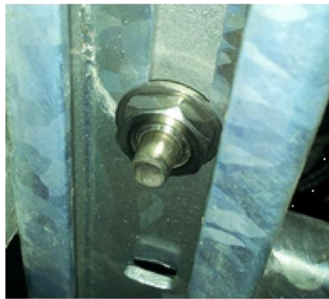
Şekil 6: Çıkarılabilir tırmanma önleyici cihazın genel görünümü
