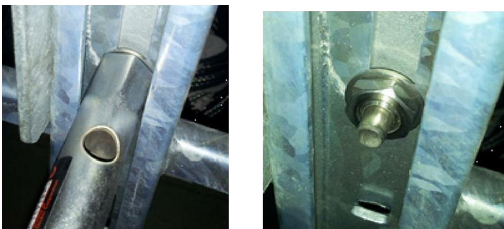
Figura 7: Instalação das porcas e posição de montagem
