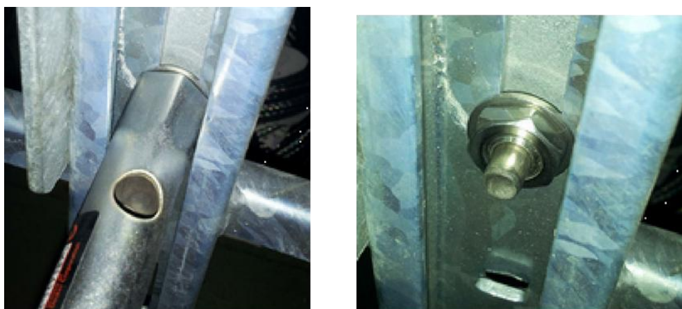
Figur 7: Montering av muttrarna och monteringsläge
