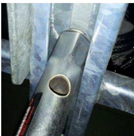
Slika 7: Namestitev matic in položaj pritrditve
