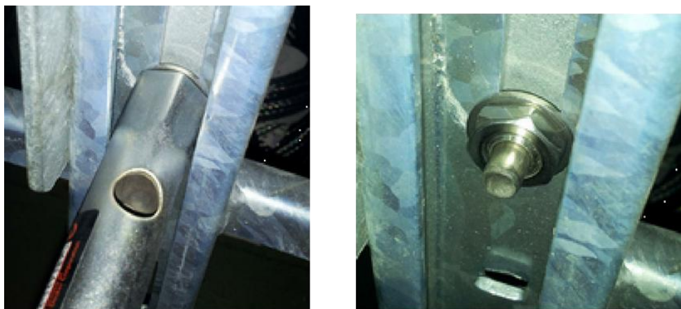
Figur 7: Montering af møtrikkerne og monteringsposition
